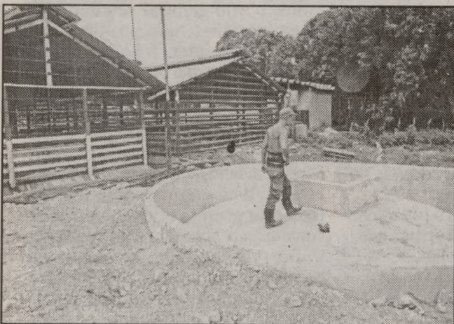
Momentos en que se terminaba de construir la planta de biogás, aledaña a la cochiguera; aquí se generará energía para la minindustria de Yoanki.
